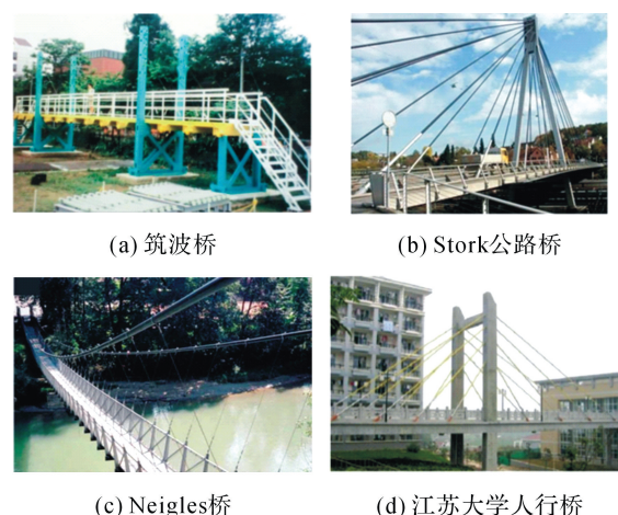
图 1 粘结型锚具桥梁实例
